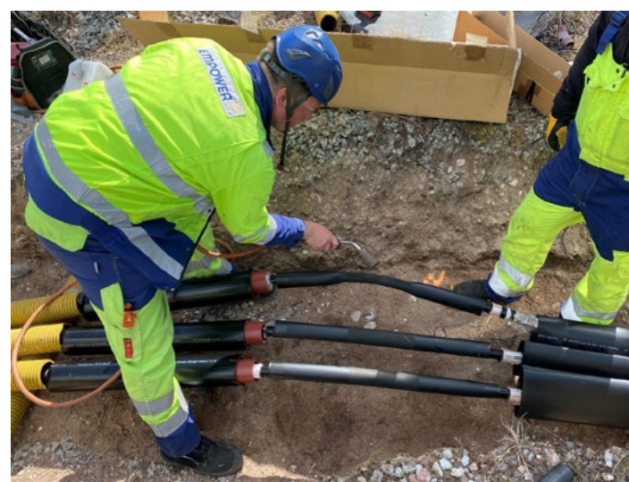
Kaablimuhvi montaaž kaevikus enne ja nüüd
