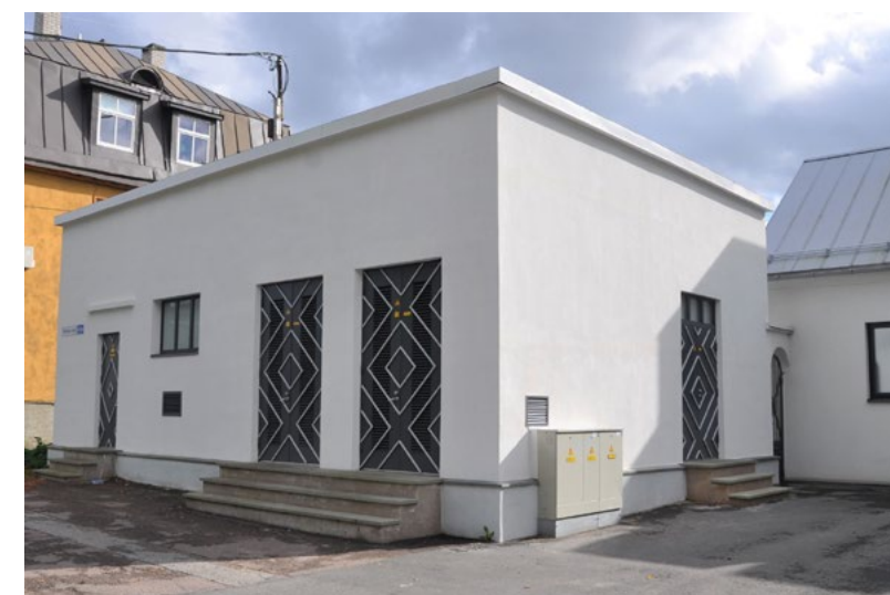
Korrastatud Elektrilevi poolt 2023. aastal
