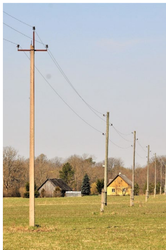
Keskpinge õhuliinidel on võetud paljasjuhtme asemel kasutusele kaetud juhe
