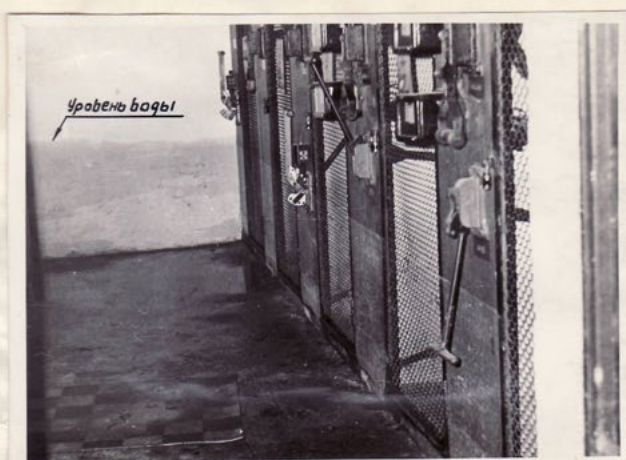
Следы затопления на п/ст 6/0,4 кв Мударавила в городе Пярну.
