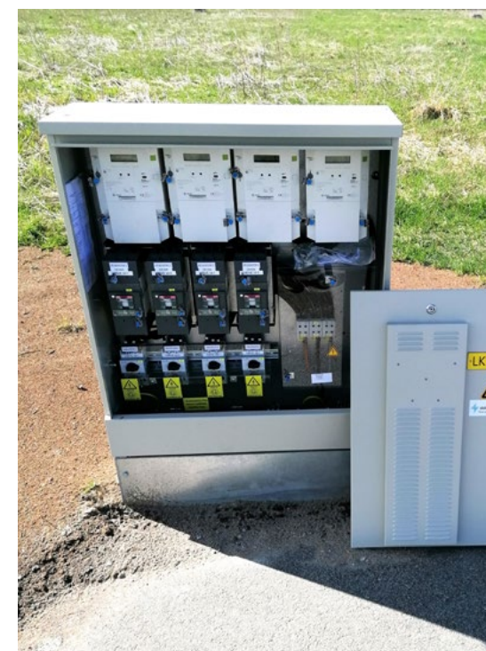
Liitumiskilbid enne sõda (Magasini tänaval) Tallinnas ja nüüd
