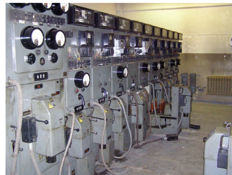
Inglise tootja Cooke&Ferguson keskpingejaotusseade paigaldati Soo alajaama 1952. aastal
