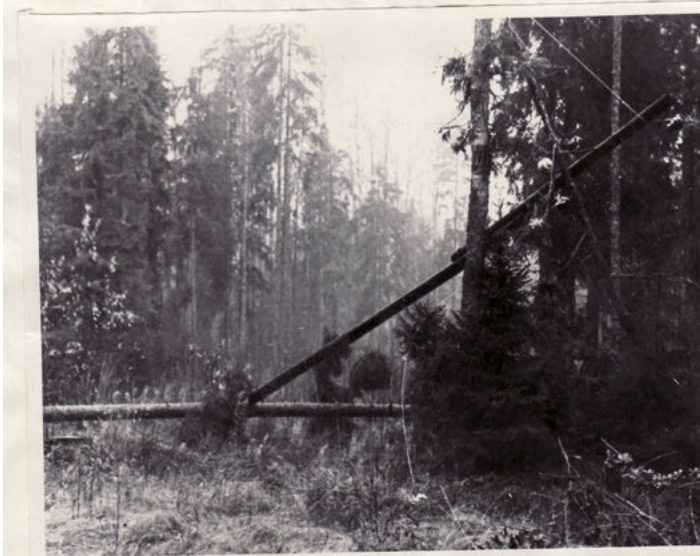
Разрушенная ЛЭП 15 кв Асуя в районе Килинги-Нымме
