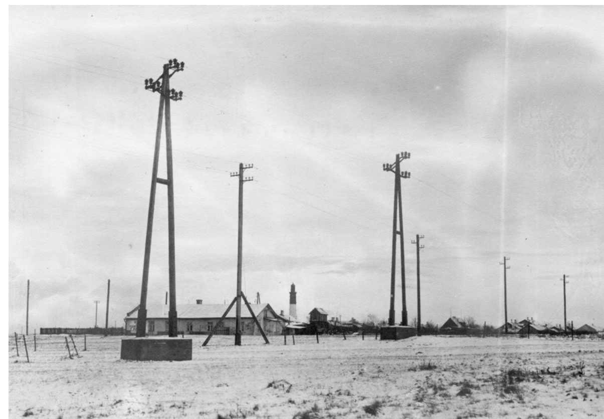
35 ja 3 kV õhuliinide mastid Lasnamäel 1937
