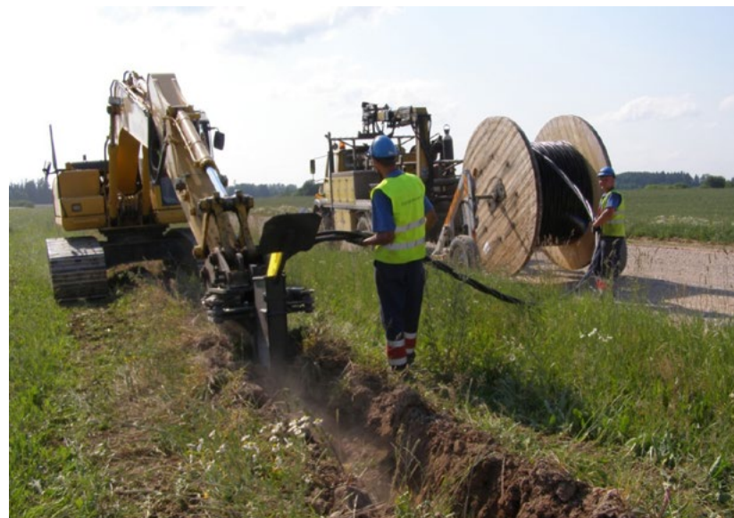
Kaabli paigaldamine Roiul „kündmise“ meetodil 2011. aastal.
