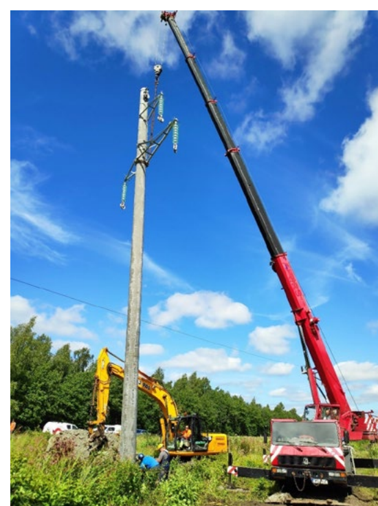
Masti püstitamine Sikassaare - Nasva liinil mõned aastad tagasi.
