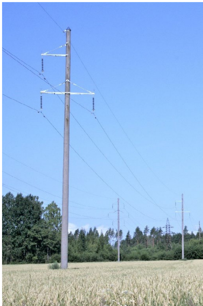
Õhuliinid 35 kV ja 110 kV pingel
