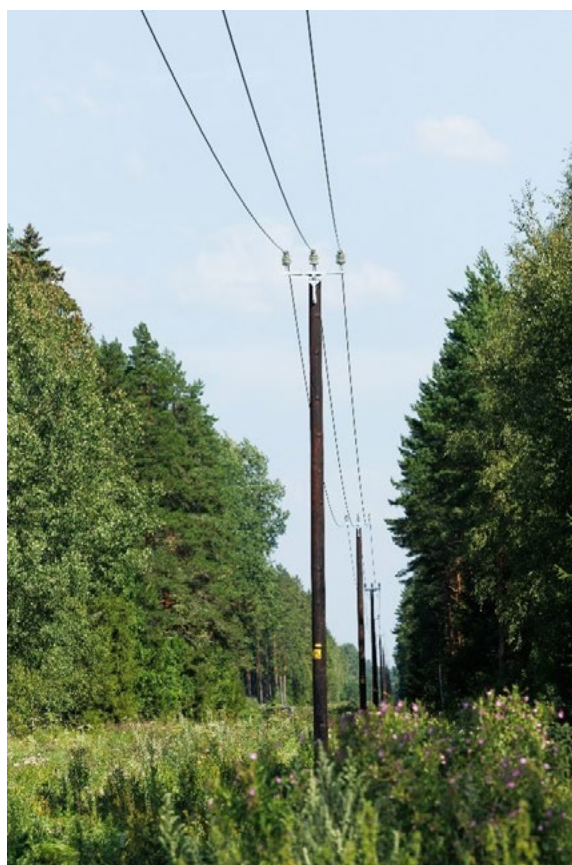
Keskpinge õhuliinidel on võetud paljasjuhtme asemel kasutusele kaetud juhe
